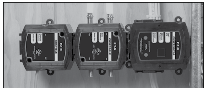
Figure 10. Joining CHSP Modules (4)/Jonción de modules CHSP (4)/Conexión de los módulos CHSP (4)
