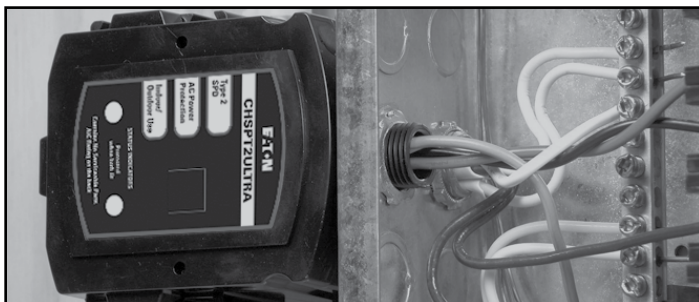
Figure 1. Panel Mount Installation (1)/Installation au panneau (1) (1)/Instalación en el centro de carga
